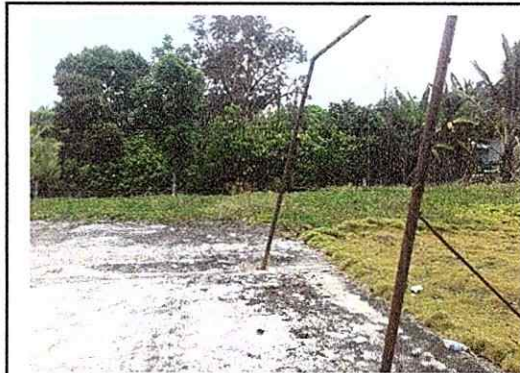
Foto 3: Circulacion del area del establecimiento en mal estado
